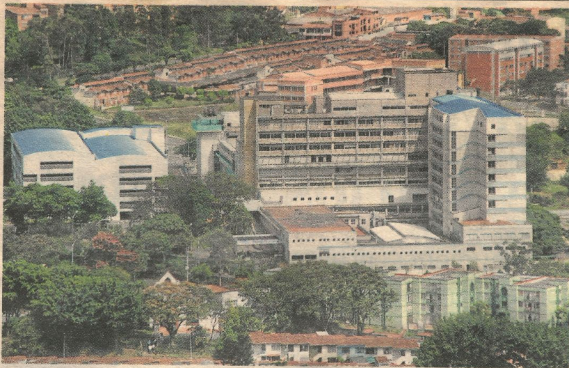
El Hospital Pablo Tobón Uribe trabaja en una nueva torre de servicios para la comunidad. ARCHIVO/ADN
