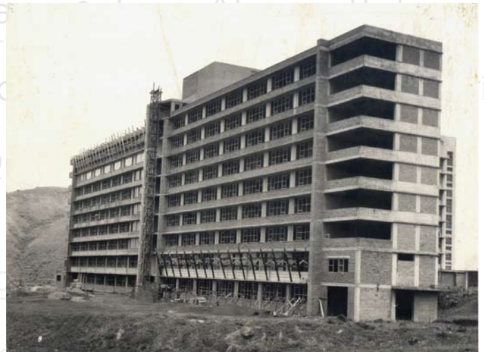
■ Edificio en obra negra.
