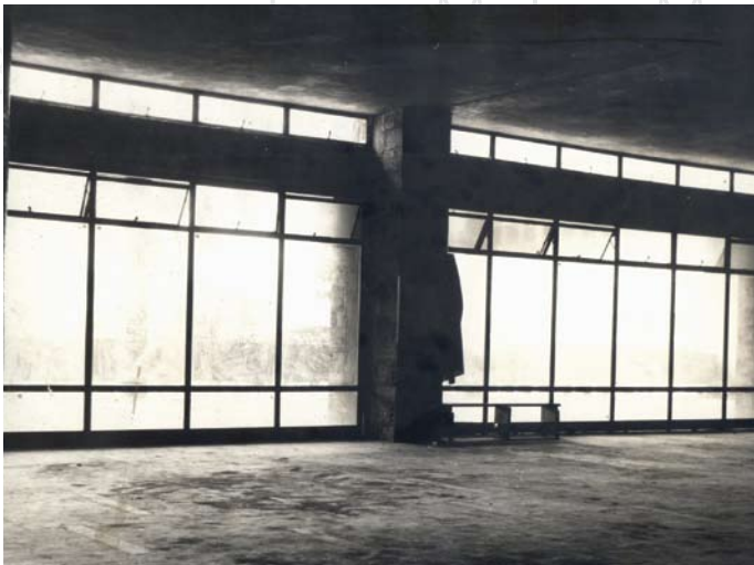
■ Interior del Hospital.
