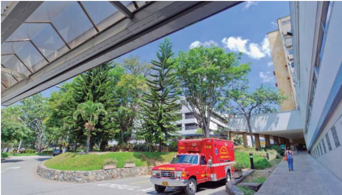
Exteriores del Hospital
