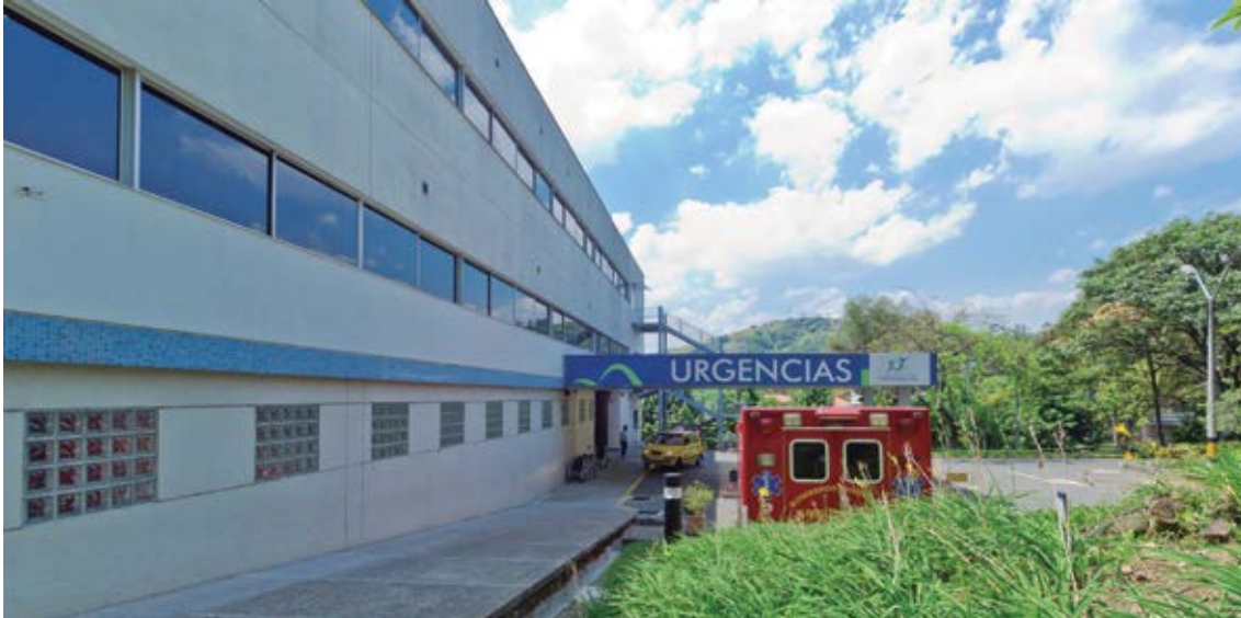
Área de Urgencias del Hospital
