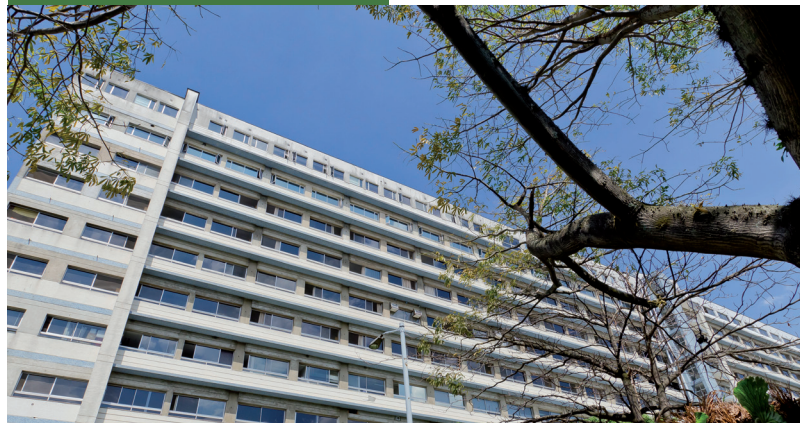
Fachada del Hospital
