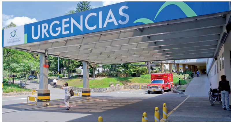
Urgencias del Hospital
