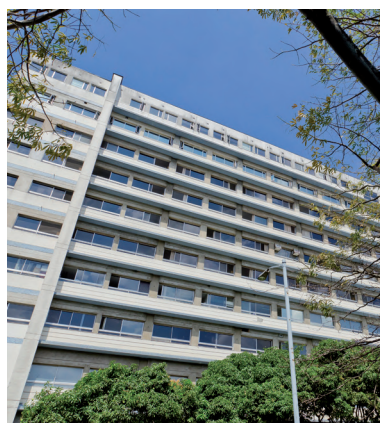
Fachada del Hospital
