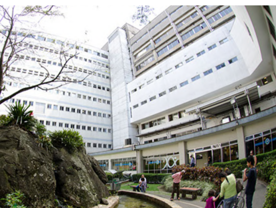
Fachada y jardines del Hospital
