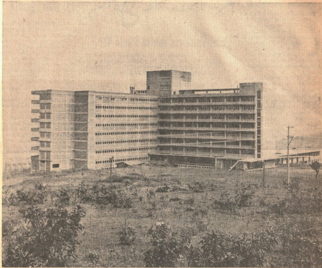
Fachada del Hospital Pablo Tobón Uribe, cuyo funcionamiento es de urgente necesidad, tal como se indica en las conclusiones del seminario sobre estado de la salud en el municipio de Medellín. La entidad cuenta con valiosos y modernos equipos que pueden sufrir deterioro y no están prestando servicio a la comunidad. En el equipo de rayos X, cuyo costo fue de 40 mil pesos. (Foto EL COLOMBIANO-Ospina).
